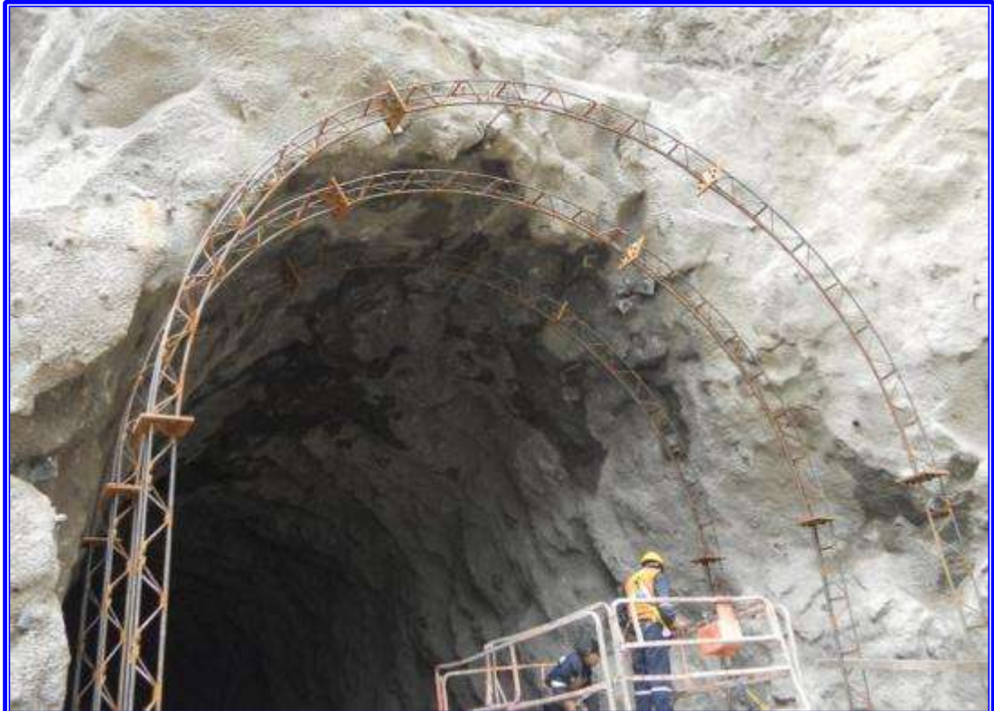
Cimbras reticuladas en obra – Túnel el Carmen
