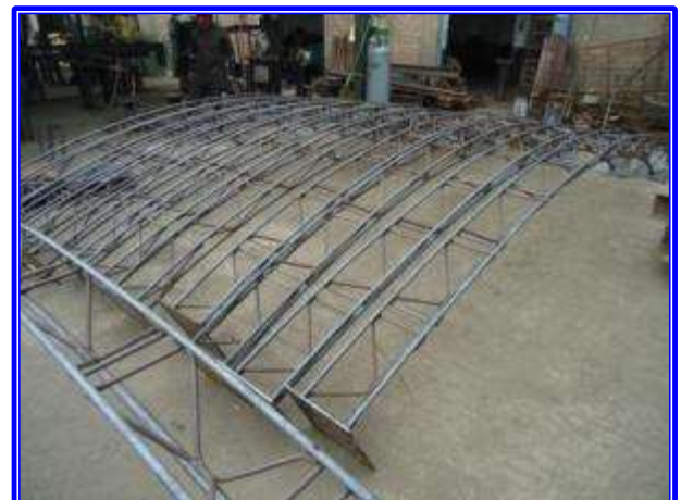
Arcos reticulados terminados – Planta FORMIN
