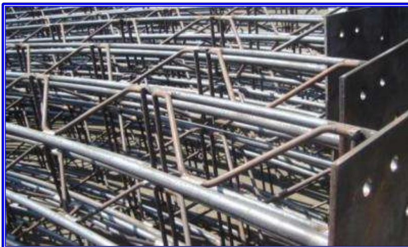
Cimbras reticuladas terminadas, apiladas y listas para su despacho
